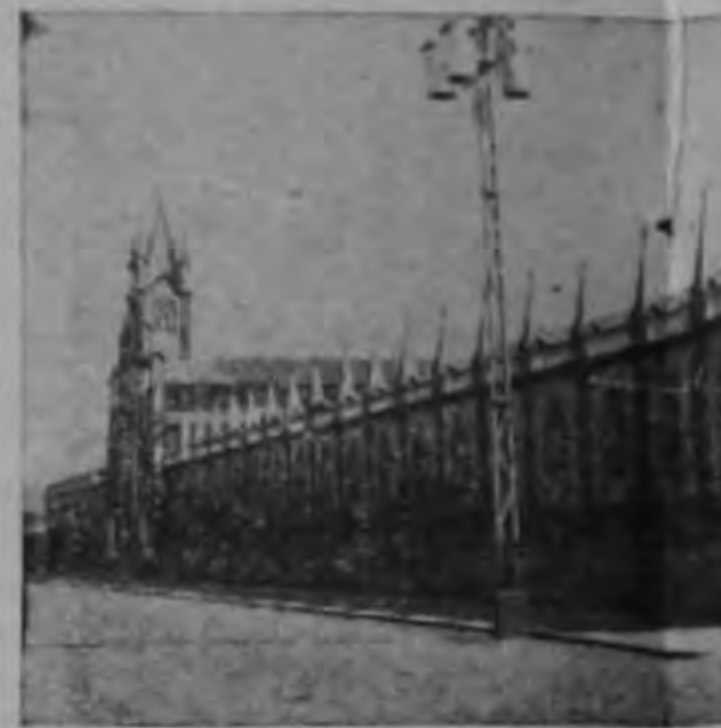
Vista de la fachada del Ed
